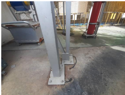
รูปที่ 34 ระบบสายดิน
