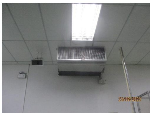
รูปที่ 29 พัดลมระบายความร้อน
