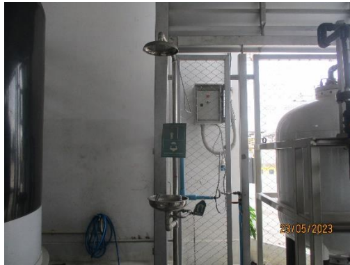
รูปที่ 26 ฝักบัวฉุกเฉินและอ่างล้างตา
